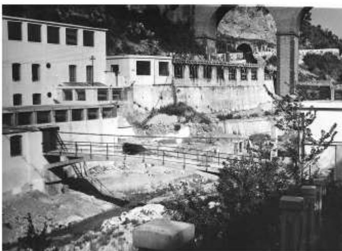
Figura 4.49 - Marina, lanificio Notari: durante la fase di ricostruzione sono ancora visibili gli apporti detritici lasciati dall'alluvione lungo le pareti della fabbrica, che poggiano quasi direttamente nel Bonea. (Coll. M. Notari, Salerno).
