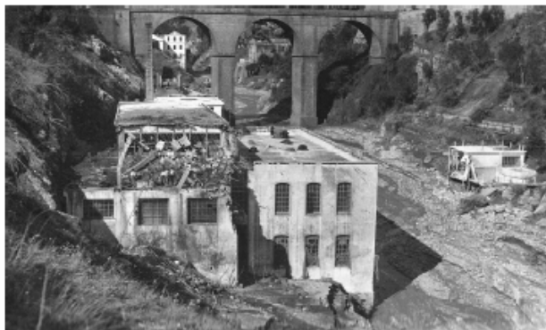
Figura 0-12: Marina di Vietri; danni ai piani superiori della fabbrica tessile Notari a seguito di una frana di modeste dimensioni staccatasi dal versante retrostante l'edificio (Coll. M. Notari, Salerno 1954).
