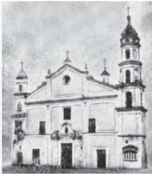
Figura 4.29 - Molina, facciata della vecchia chiesa di S. Maria della Neve (da A. Miranda, Molina di Vietri sul Mare dalle origini ai giorni nostri , Salerno, 1971).
