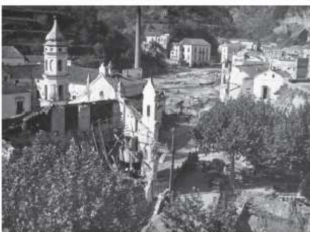
Figura 4.32 - Molina, la vecchia chiesa di S. Maria della Neve subito dopo l'alluvione del 1954, è evidente il crollo parziale del tetto e dell'intero lato orientale (Foto Parisio, Coll. EPT, Salerno, 1954).
