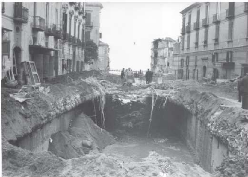
Figura A-7 Maiori, completo sfondamento della copertura del canalone che raccoglieva le acque del Torrente Regina Maior (Foto del Servizio Idrografico e Mareografico di Napoli, 1954).
