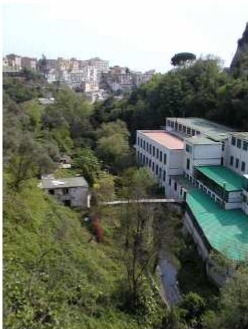
Figura A-3 Edifici (fabbrica di ceramica Solimena, ex Notari) costruiti nell'alveo del Torrente Bonea presso marina di Vietri (Foto Violante).
