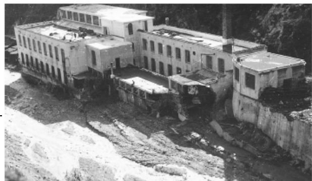
Figura 0-11: Marina di Vietri; danni alla fabbrica tessile Notari. Una porzione
