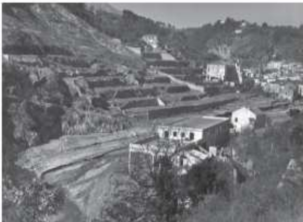
Figura 0-10: Molina di Vietri. In basso la cartiera Camera situata sulla sponda sinistra del Torrente Bonea, subì notevoli danni al piano terreno, con l'abbattimento delle mura perimetrali ed interne dell'edificio (Foto Parisio, 1954, Coll. EPT, Salerno).
