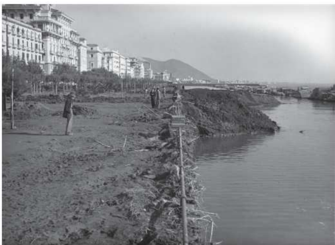
Figura A-6 Salerno, accumulo di materiale alluvionale sul lungomare (Foto Parisio1954, Archivio EPT, Salerno).
