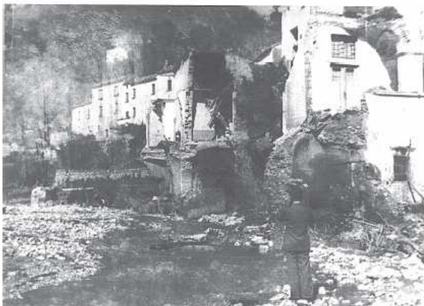
Figura 0-7: Molina di Vietri. Danni riportati dalle abitazioni poste in sinistra orografica del Bonea (Coll. Habitat, Raito).
