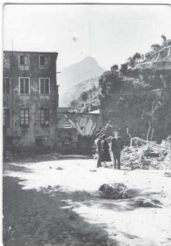
Figura 4.53 - Opificio industriale d'Ambrosio: danni prodotti dall'alluvione del 1954 alla vasca di raccolta dell'acqua per la produzione di energia elettrica mediante turbina (Coll. d'Ambrosio, Vietri sul Mare) .
