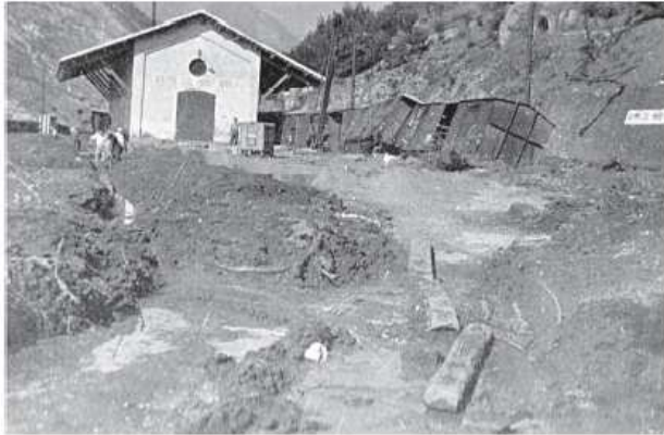
Figura 0-4: Stazione di Vietri sul Mare. Depositi di frana provenienti dal versante sud-occidentale del Monte S. Liberatore formano una estesa coltre spesso più di un metro (Coll. Habitat, Raito, 1954).
