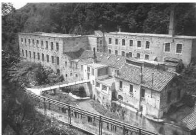
Figura 4.45 - Marina, il lanificio Notari, foto degli inizi del '900 in cui è visibile l'ampliamento del corpo di fabbrica (Coll. M. Notari, Salerno).
