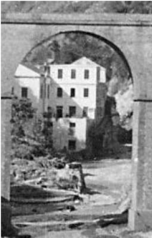
Figura 4.41 - Molina, area della ramiera Costa e fabbrica Cavaliere dopo l'alluvione del 1954 (Collezione M. Notari, Salerno).
