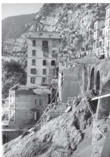
Figura A-5 Salerno, Rione Olivieri, crollo di abitazioni lungo la Strada Statale 18 Vietri sul Mare - Salerno (Foto Parisio 1954, Archivio EPT, Salerno).
