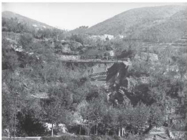
Figura 0-2 Tratto ferroviario Vietri sul Mare-Cava de' Tirreni. Fenomeno fr anosche interessò un'ampia area a confine tra i due comuni, coinvolgendo sia la strada statale 18 sia la rete ferroviaria, (Foto Parisio, 1954, Coll. EPT, Salerno)
