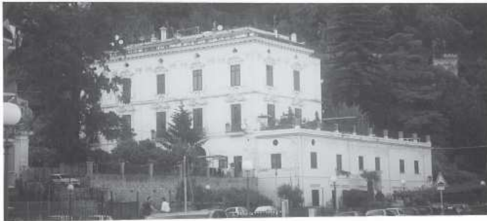
Figura 4.56 - Marina, Palazzo Pellegrino dopo la ricostruzione post-alluvione, in una foto recente (Foto A. De Pasquale, Vietri sul Mare).
