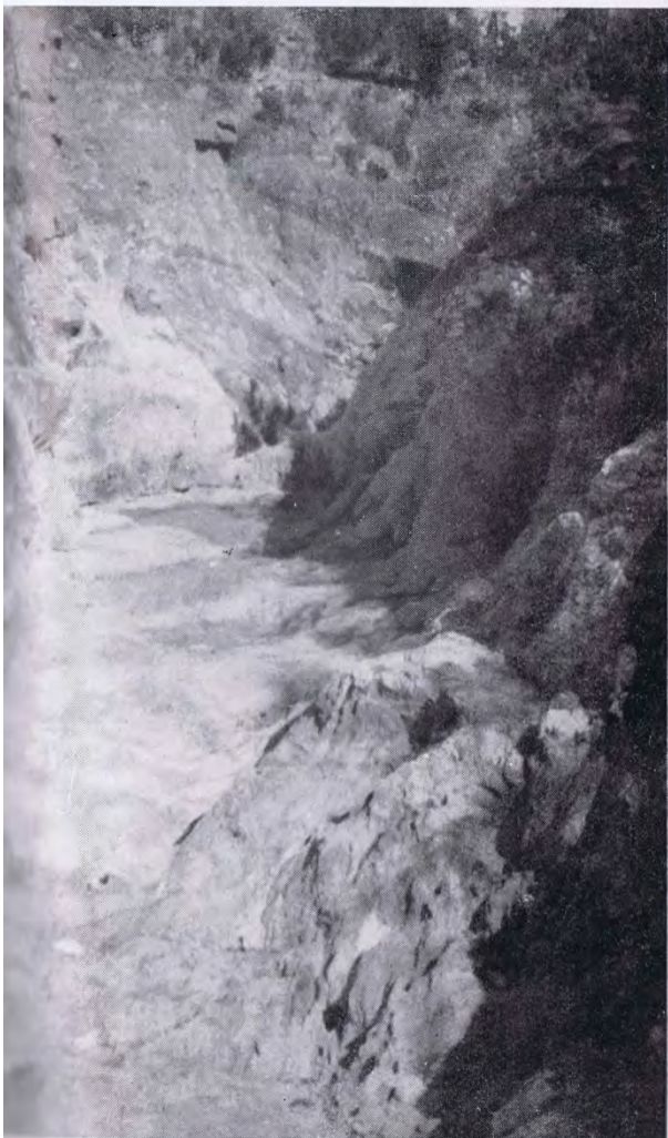
Fig. 6: Erosione di un collettore con azione di levigazione (Vallone Fuonti in Comune di Tramonti). (Foto Leica).
