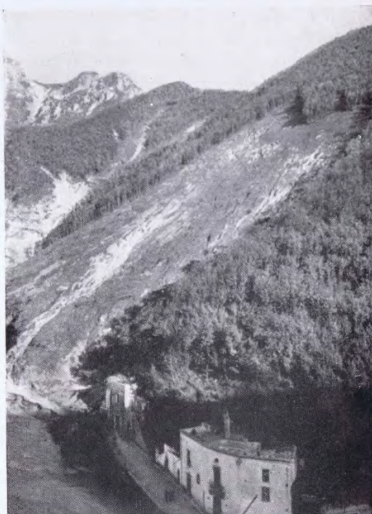
Fig. 3: Frana per distacco di terreno a Ponteprimario (Comune di Maiori).
