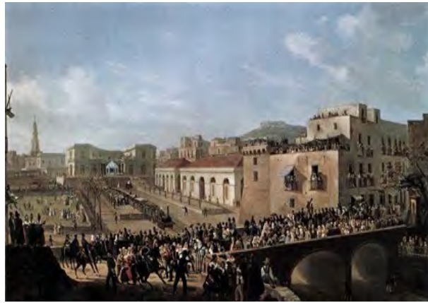
S. Fergola, Inaugurazione della Regia strada ferrata Napoli – Caserta (1845)
