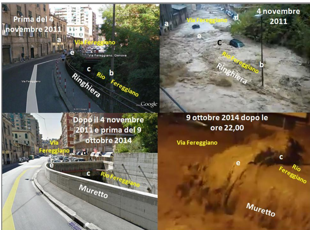
Figura : Le immagini in alto illustrano l'ultimo tratto dell'alveo scoperto del Rio Fereggiano prima del nubifragio del 4 novembre 2011 (a sinistra) e durante l'esondazione ( a destra). Si nota che la strada in sinistra orografica (foto in alto a sinistra) era protetta dal Rio Fereggiano da una ringhiera che è stata completamente sommersa durante l'esondazione (immagine a destra). L'immagine in basso a sinistra evidenzia che dopo il disastro del 4 novembre 2011 la ringhiera è stata sostituita con un muretto in calcestruzzo che ha certamente contenuto l'esondazione ma non la ha impedita (immagine a destra).
