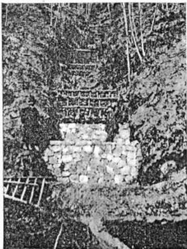
Fig. 5. - Briglie di muratura a secco.
