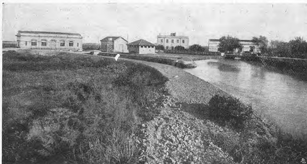
Bonifica Vicana : veduta d'assieme degli impianti idrovori dal canale di scarico
