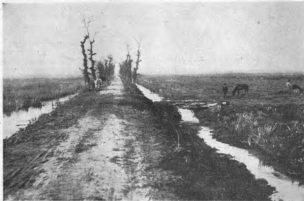
Campagna Vicana : argine di separazione tra il polder della 1 a zona (a destra) e le gronde paludose del Lago di Patria (a sinistra)
