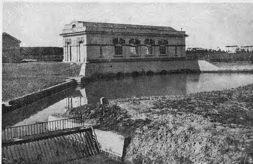
Bonifica Vicana : impianto 1928 dalla vasca di raccolta
