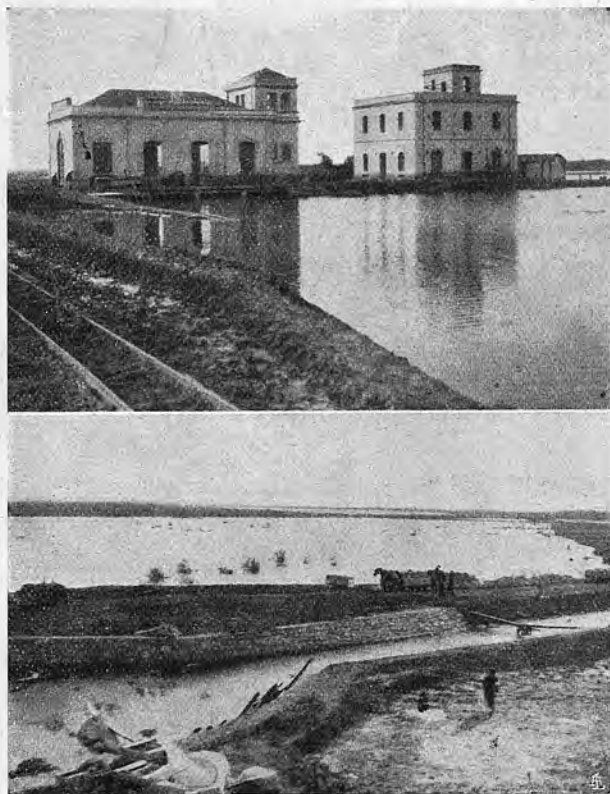
Consorzio Castelvoturno: in alto , fabbricato idrovore ed alloggi; in basso , vasca di scarico e canale
