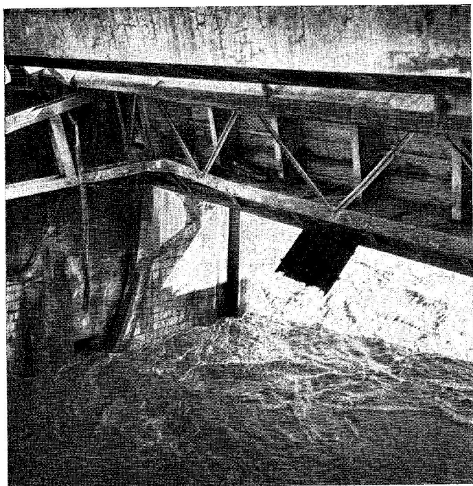
L'ondata di piena si scaglia con violenza contro la traversa di Ponte Annibale
