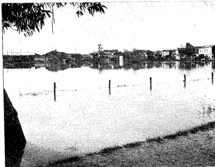
Le opere di bonifica completamente distrutte dalla furia delle acque
